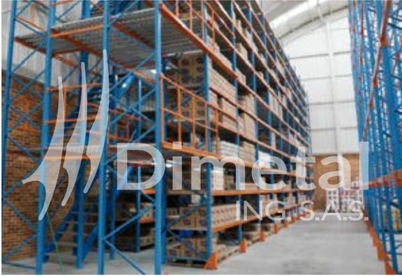
Suministro e instalación de 19 Módulos de Estantería Pesada, de dimensiones de 9 metros de altura; 2.438 metros de largo y profundidad de 1.066 metros, 12 niveles de almacenamiento, 11 sobre vigas con capacidad de almacenamiento de 1000 Kg (par Vigas) Modulo Tipo A y UNO a piso. Para un total de Almacenamiento de 209 niveles de 2,438 mm y 5 niveles de 1.174mm.
